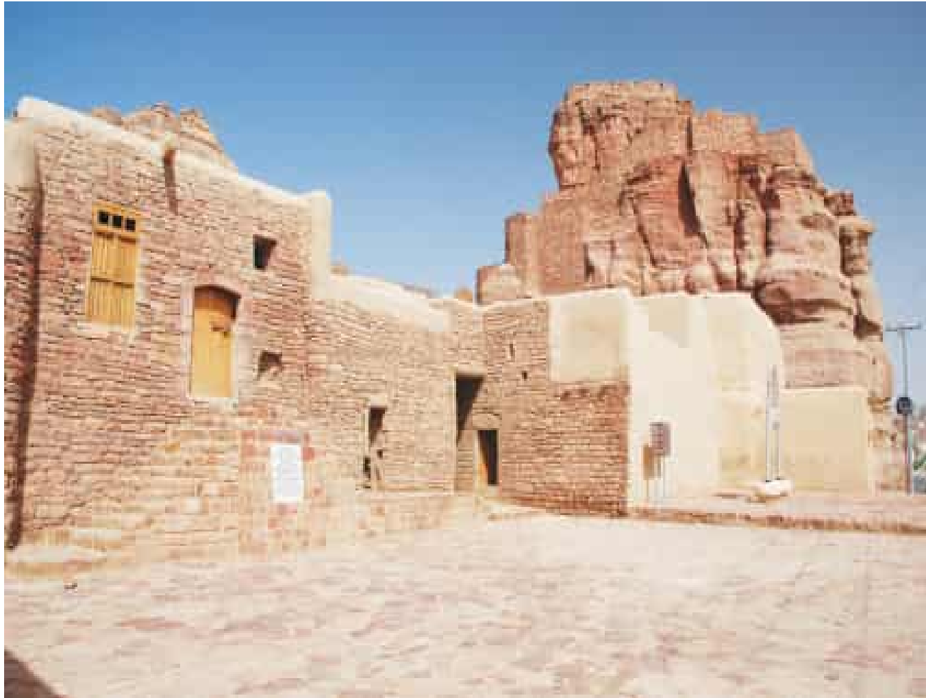
القلعة للمراقبة والحماية The Castle for Protection and control. ( Alula – Old Town )
